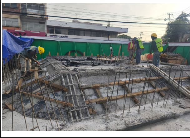
DESCIMBRADO DE CONTRATRABES
