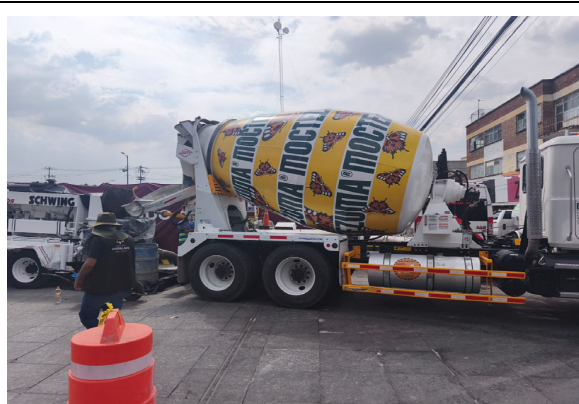
LLEGADA DE CONCRETO A OBRA
