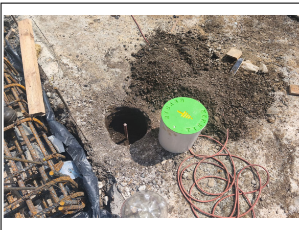
COLOCACIÓN DE VARILLAS Y CABLE DE PARARRAYOS
