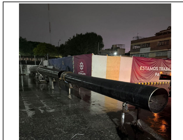
LLEGADA DE TUBOS DE ASTA A SITIO
