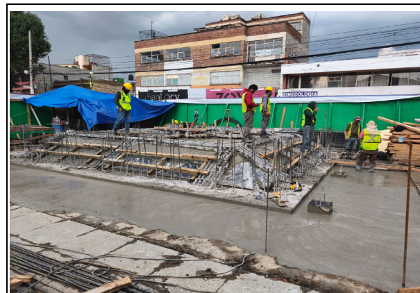
COLADO DE LAS CELDAS ENTRE CONTRATRABES
