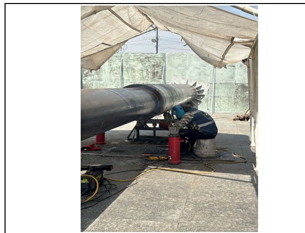
TRABJOSDE SOLDADURA DE POSTES DE ASTA
