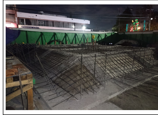
COLADO DE PISO PERIMETRALES
