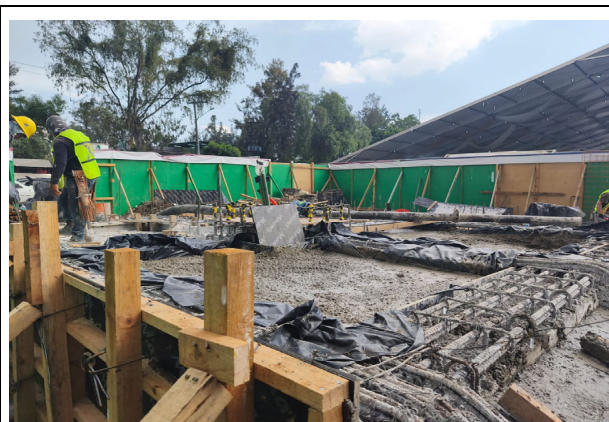
COLADO DE LAS CELDAS ENTRE CONTRATRABES
