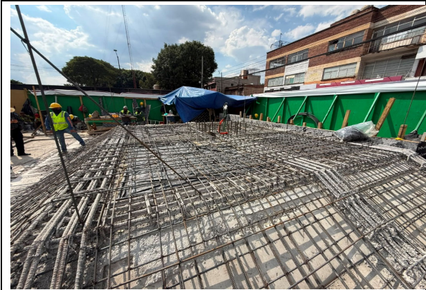
ARMADO DE ACERO DE LOSATAPA
