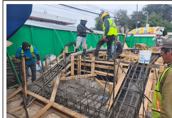
COLADO DE CONTRATRABES
